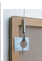
パネルにネジで金具を取り付け
