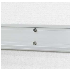
木壁用ネジで取り付け
